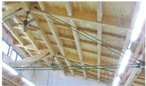
トラス構造(AT Aハイブリットトラス)の事務室
